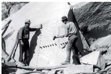
Scalpellini durante il taglio del granito.
